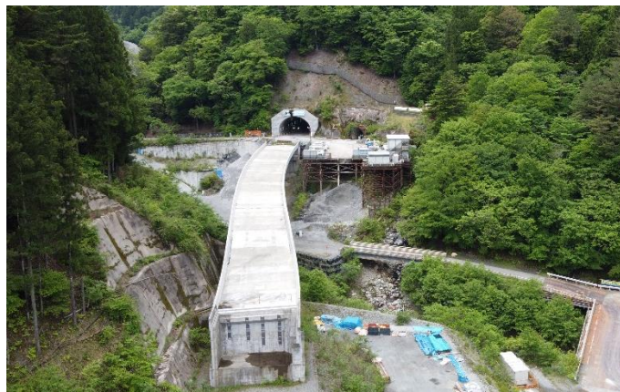
三遠南信自動車道青崩峠トンネル(仮称)南信濃側
