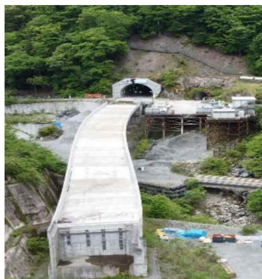
青崩峠トンネルの坑口（長野県側）
